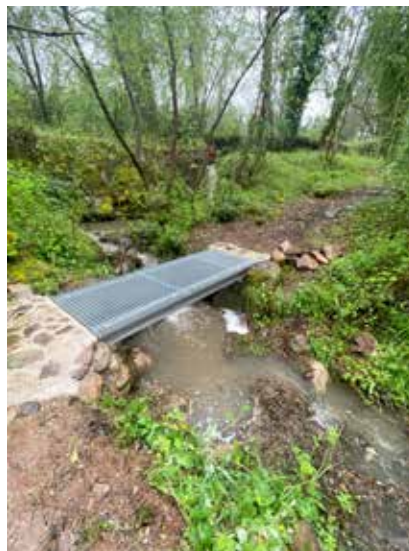
Passarel·la, construïda per la brigada municipal, al camí de la Pobleta a Antist
