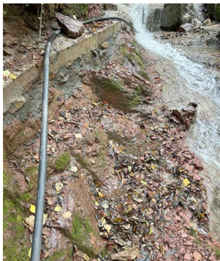
Nova portava d'aigua al dipòsit regulador de Castell-estaó
