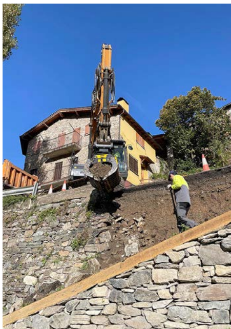
Reparació del mur d'escullera a la carretera de Mont-ros
