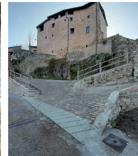
Substitució del paviment d'un camí a Antist
