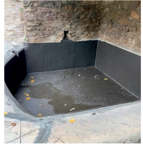
Reparació de fuites al com de Pobellà
