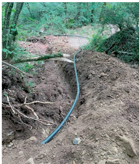
Nova portava d'aigua al dipòsit regulador de Castell-estaó
