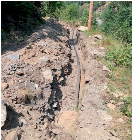
Canvi de la canonada de la captació de la Central (1a fase)
